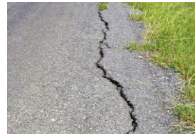
Edge Cracking
